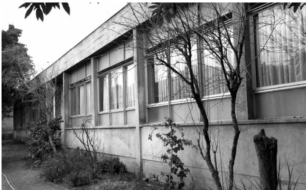
Vista lateral del pabellón de salas de clases edificado en 1979. Su construcción permitió completar la infraestructura del complejo educativo.
