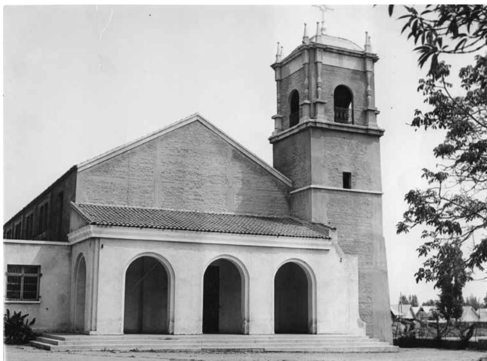
Fachada de la capilla, ca. 1960.
