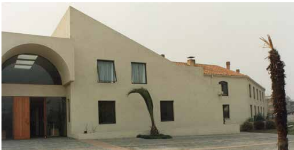
Fachada principal y acceso al Pabellón Madre Petra por avenida Alcántara. 1993.
