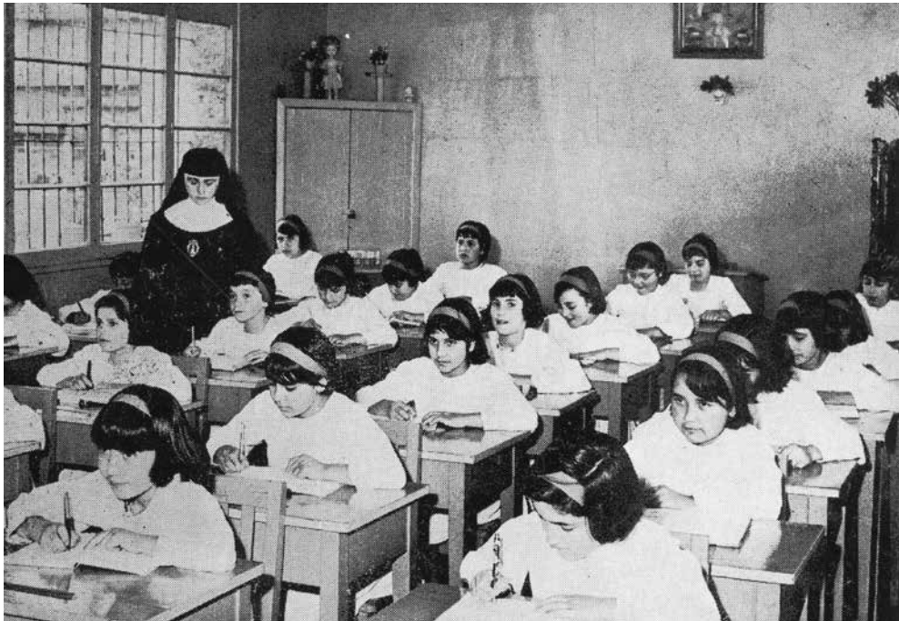
Una de las salas de clase del nuevo edificio.
